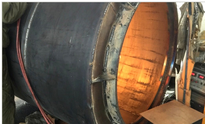
02 车间·大口径环缝焊接
