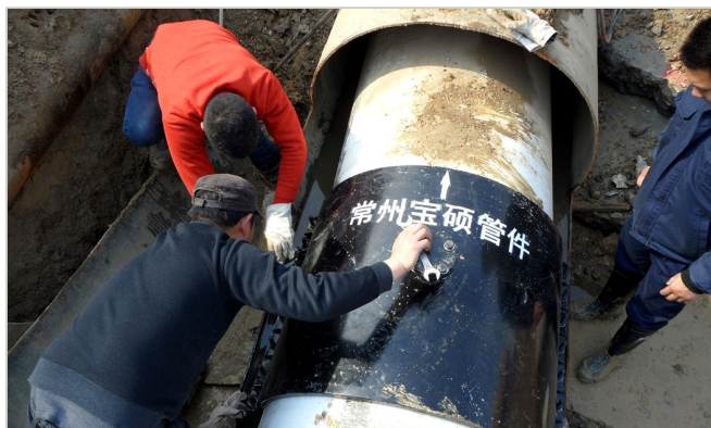
04 现场安装·直管段不停水抢修
